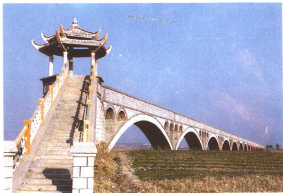
西野渚泊扬水站渡槽
