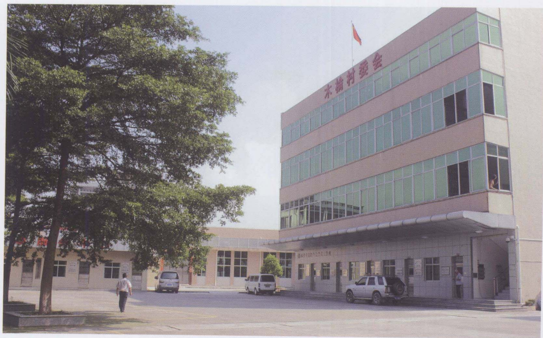
木榆村委会办公大楼
