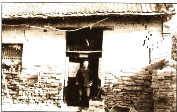
解元集房屋震裂
