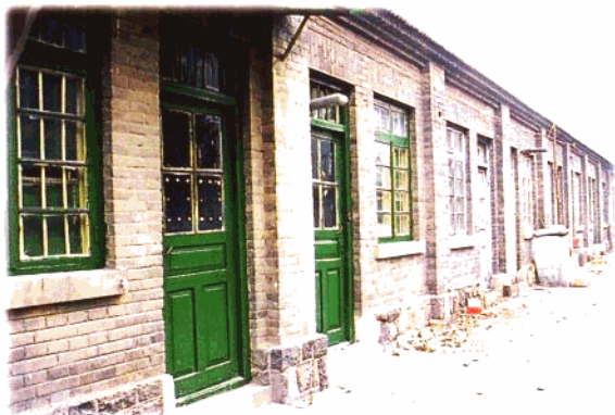
山东省地震工作中心站旧址
