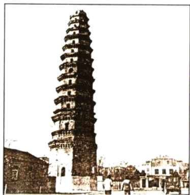
汶上县塔顶震落
