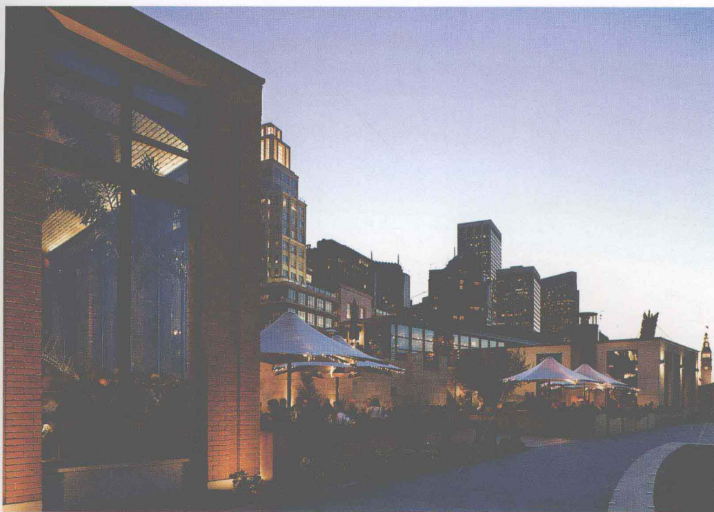
Rincon 餐厅： 借鉴了著名餐厅老板Pat Kuleto两个全新的餐饮理念，位于圣弗兰西斯科的Rincon 公园——一个毗邻的公共滨水设施。由一个广场将两个建筑分隔开，这两个建筑由Pat Kuleto和Engstrom设计公司MBH建筑设计建造。
