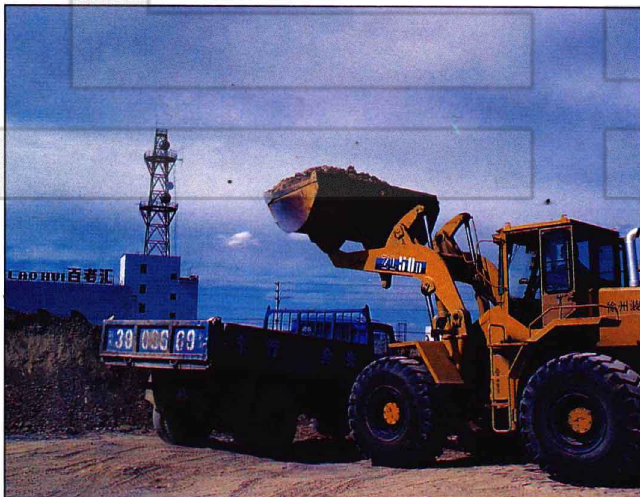
建安公司在施工
