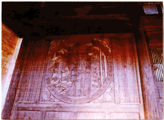
建甌光孝寺木构梁柱及楠木画屏
