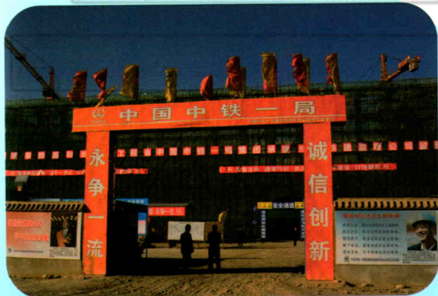
建设中的和田火车站
