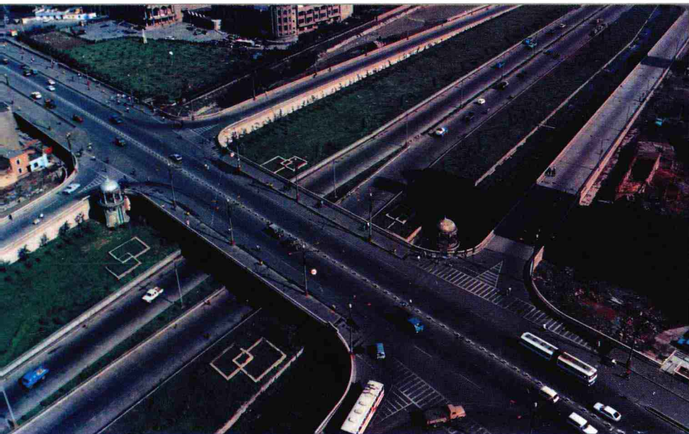
烏魯木齊市人民路立交橋
