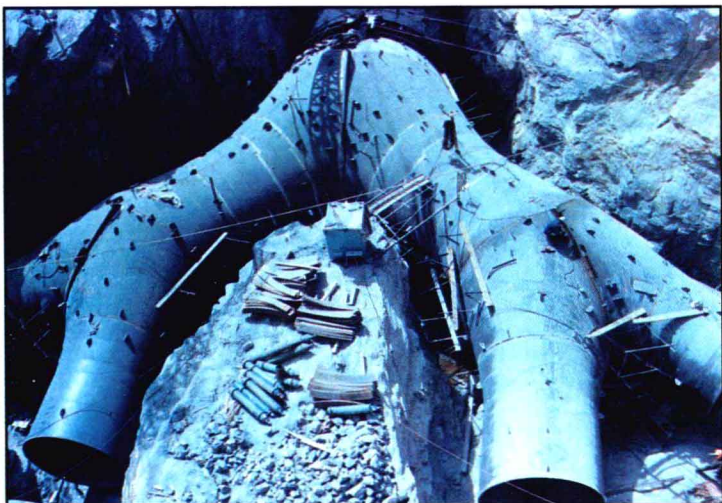
用于山口水电站的 Y- \Gamma 组合式内加强肋钢管
