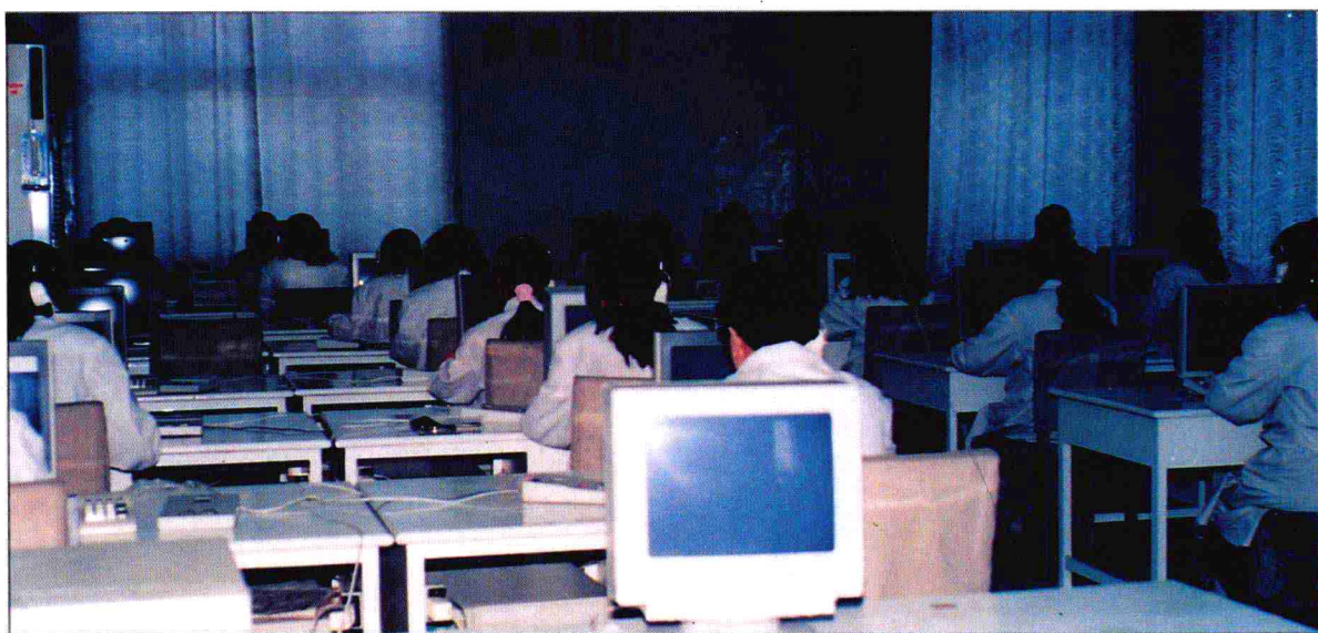
烏魯木齊市電信局 181 無線尋呼臺機房
