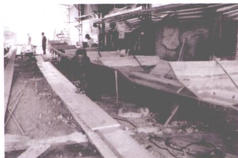
(河的某一段河底，掩放龙舟之处)中挖上来，然后清洗瘀泥，用几条小船把龙舟托起(叫“晾水”，俗称“确水”)，然后用砂纸打磨，上油(一般用桐油，若是参赛前的“晾水”，水份干却后还要加抹猪板油)，近十年来，桐油和猪油都“不合格”了，干脆上光漆油，一次搞掂，省事且效果好。赛前还要调校龙舟的“刚度”(根据划手总重量而确定船两头翘起的高度)，“龙骨”之间，每隔80公分结相连，中间插入一木楔，结便抽紧，船两头随之翘起，随意调校。在河底的龙床叫“水床”，近20年来，多已改革为“旱床”，旱床就是搭一个遮阳挡雨的窄长木棚，把龙舟用横木离水托起，用船时可随时把船放下。“旱床”比“水床”省事得多了，且更有利于延长杉木型龙舟的使用寿命。
