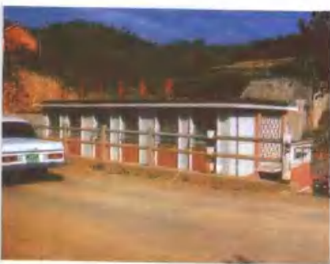
△老君庙水电站
