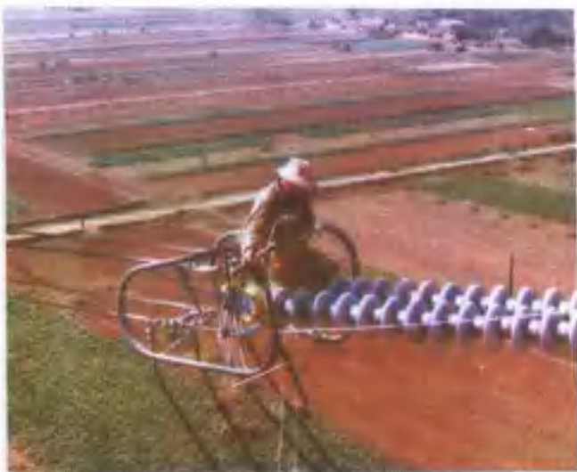
△500KV 输电线路高空作业
