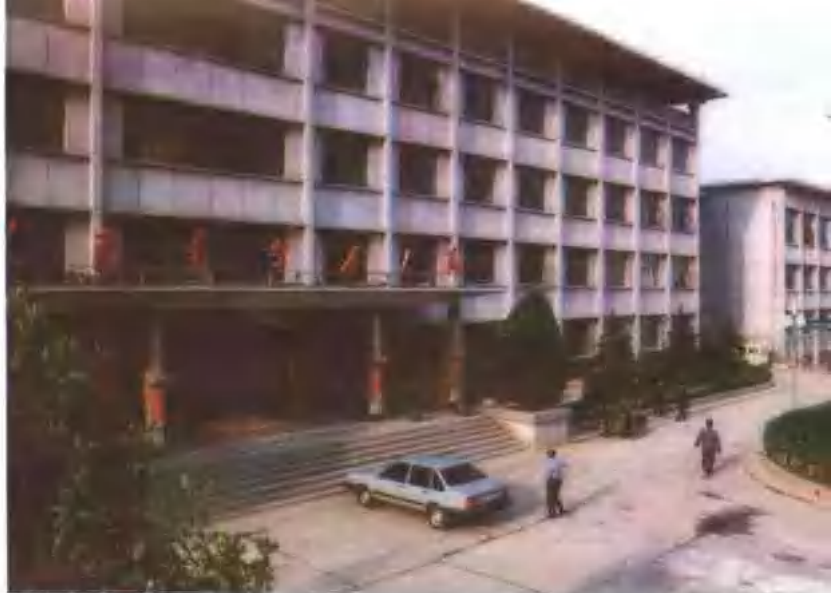
▷ 南阳地区电业局 局办公大楼
