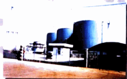
岚山沥青站沥青罐群
