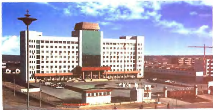
磁县综合办公大楼
