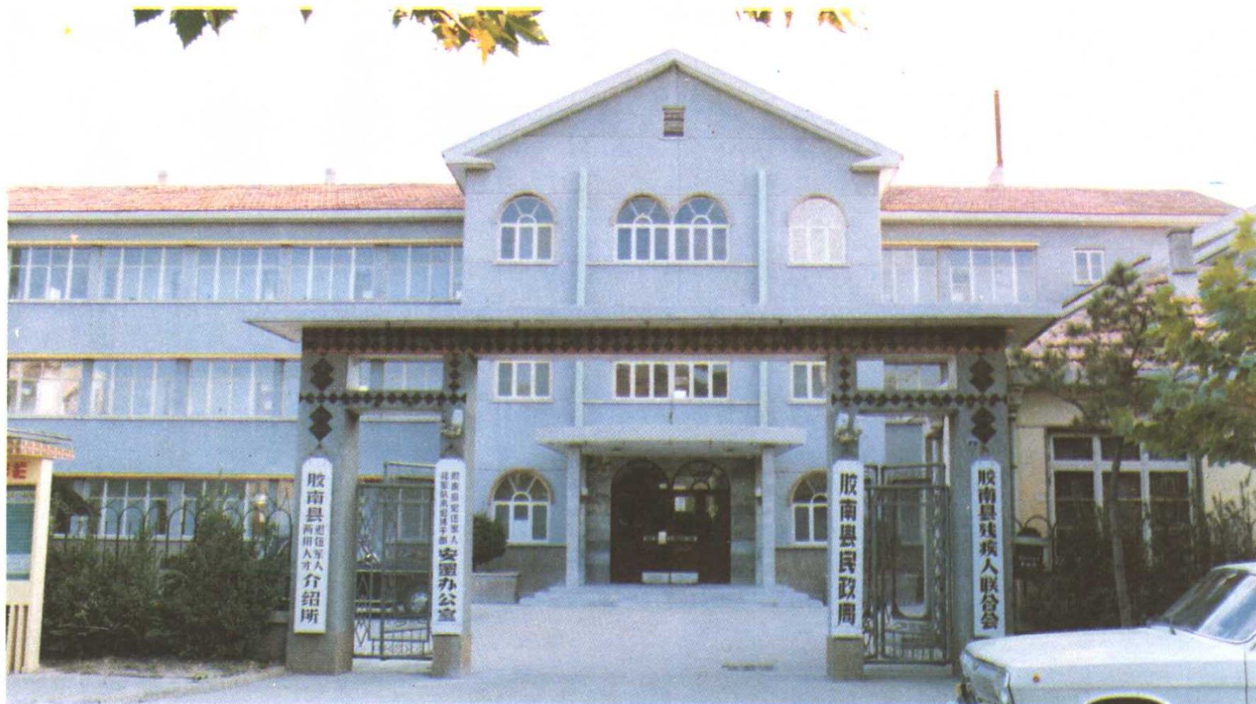
胶南县民政局办公楼
