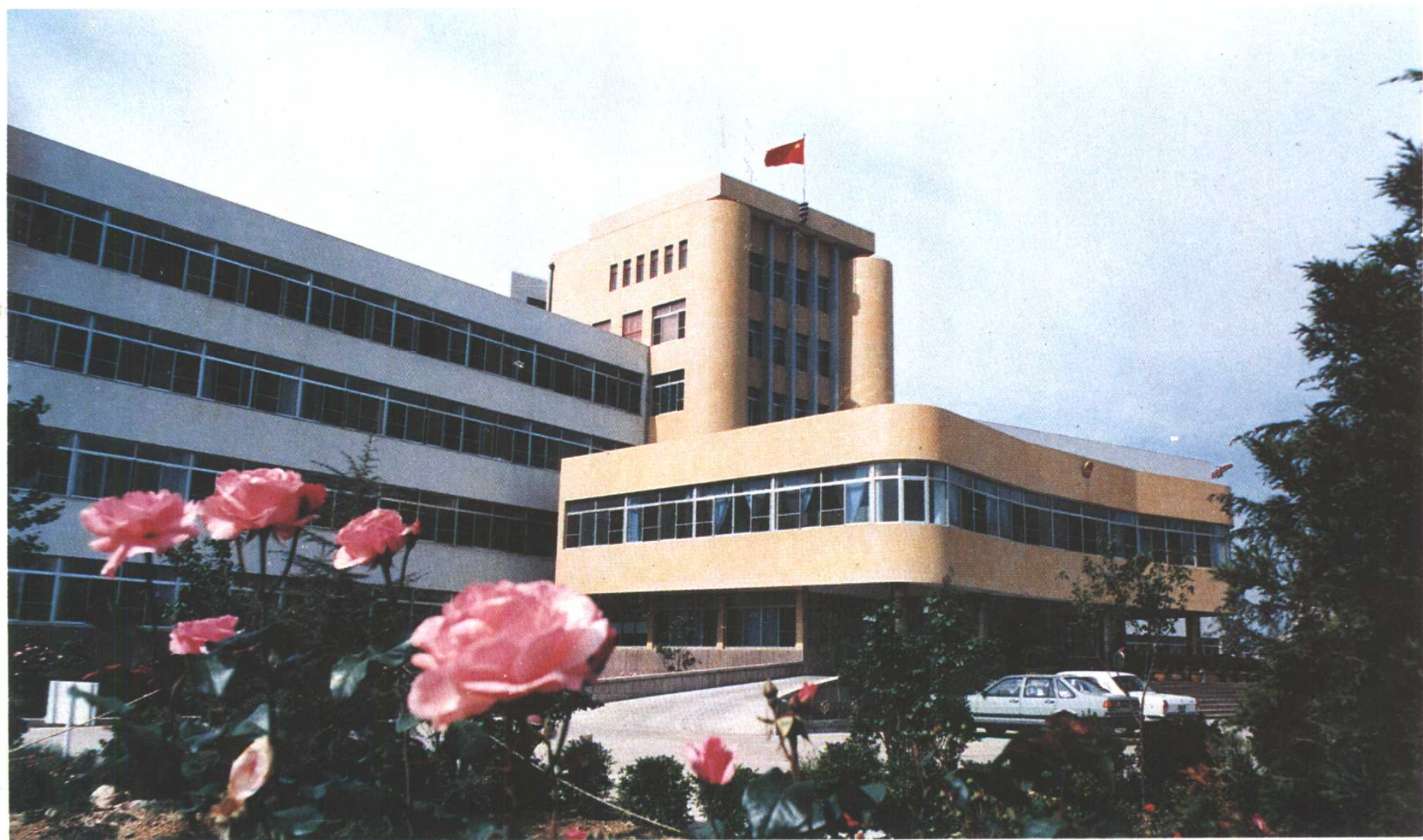
胶南县人民政府办公楼
