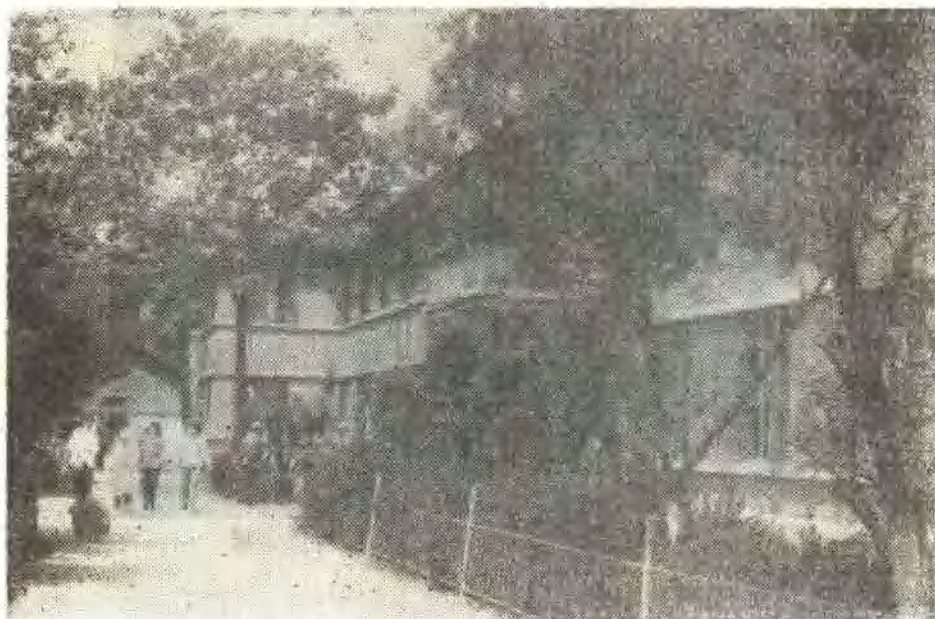
商丘市人民医院病房楼外貌
