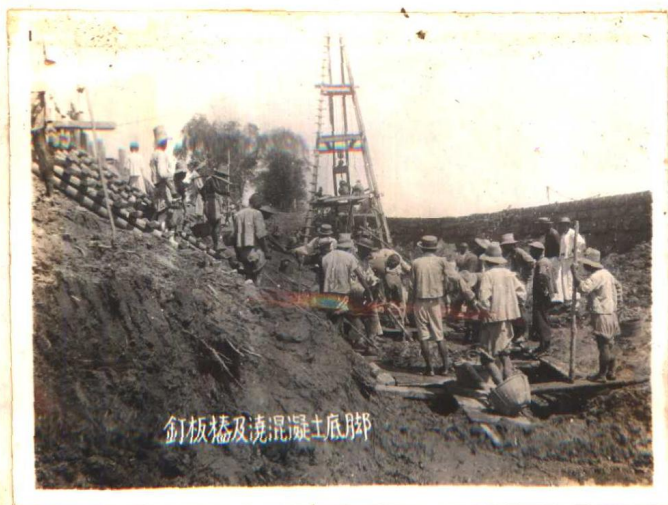
釘板樁及澆混凝土底脚
