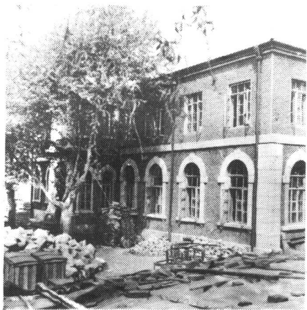
修复前的勤民楼。（张立宪 提供）
