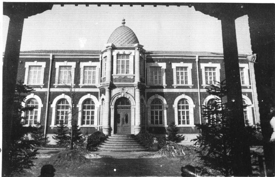
修复后的勤民楼。（张立宪 摄）
