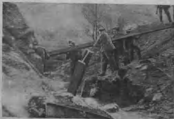
工橋架的段地壘崎 字工用利兵士，程 的樑橋固鞏以條鋼 器兵重利以，脚基 山多在這，輸運的 便是中戰作的城區 。的需必
