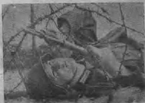
衝鋒時用鉗鉗割斷鐵網的方法，當時敵方火網極密，執行此項工作者，處境非常危險，故必須爬行及使本方的機關火力為其掩護後方能完成此項任務。
