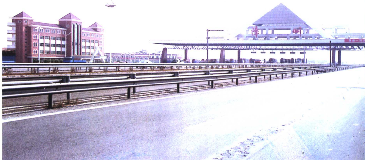
厦漳高速公路
