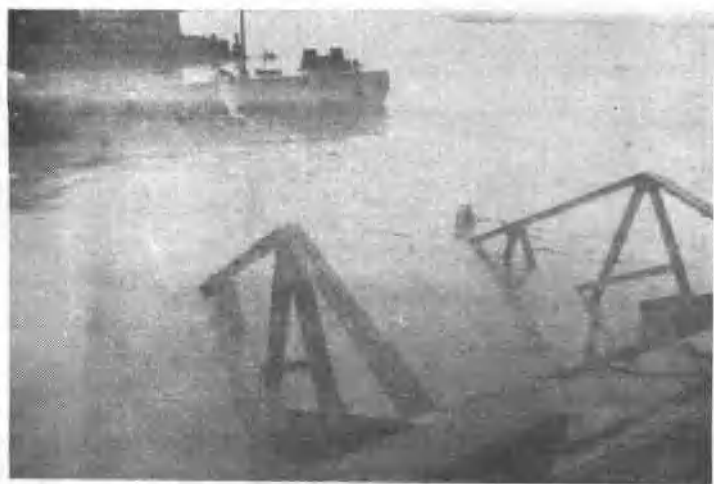
9417 号台风袭击瑞安,城关南门码头受损情况 管 陶 摄
