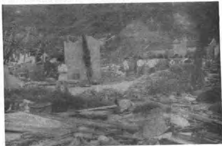
9417 号台风瑞安, 房屋倒塌情况
