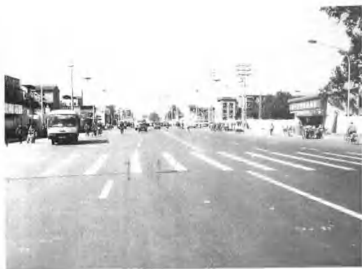
连通江滨的建宁路西延工程
