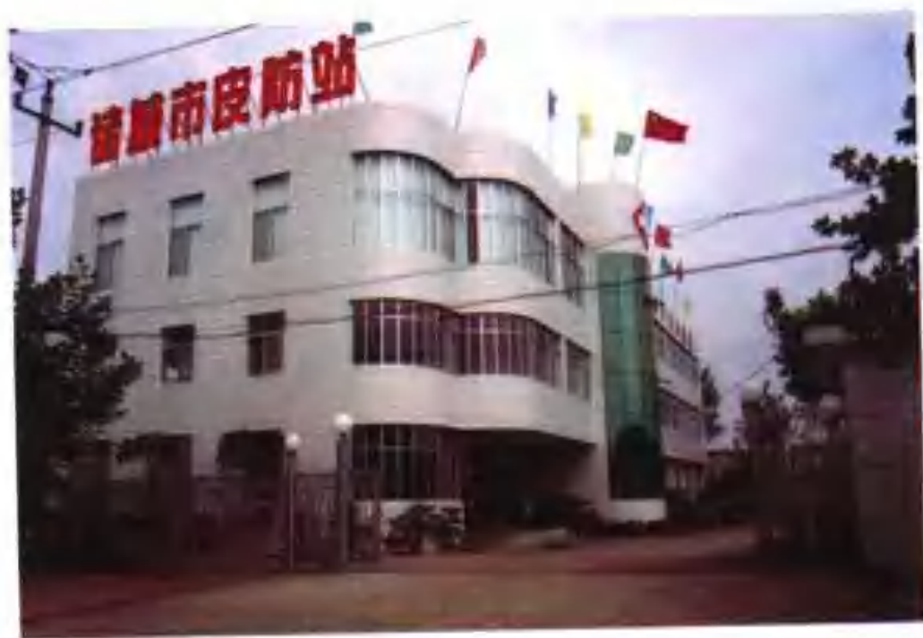
现皮防站综合门诊大楼
