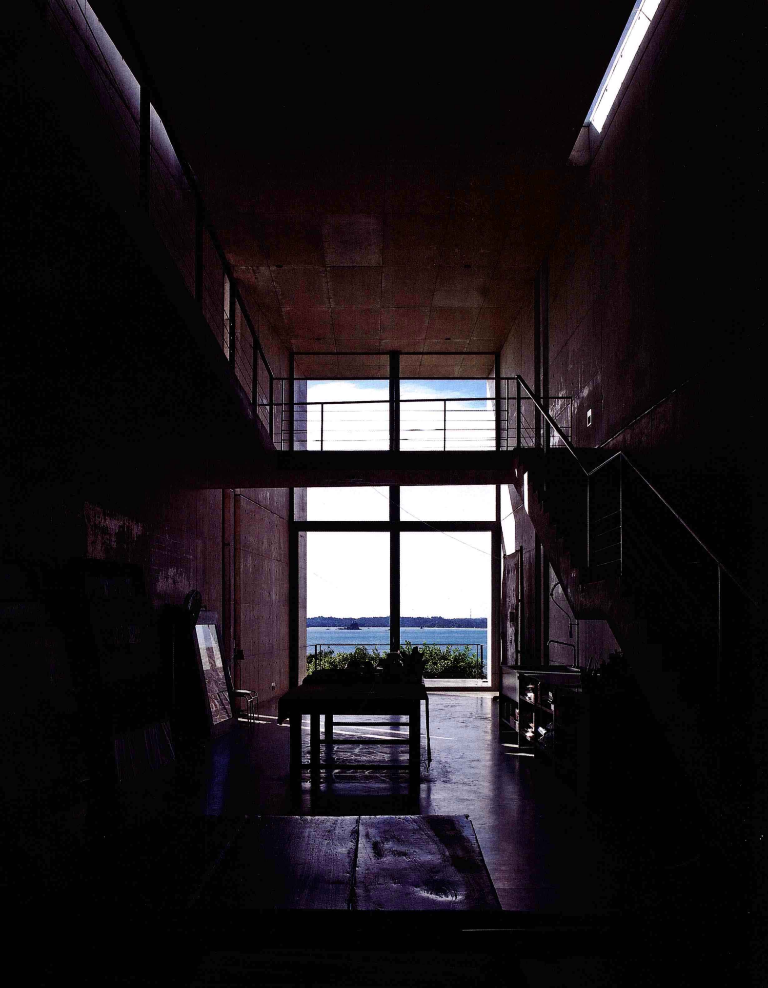
1階アトリエは、アーティストである夫人が静かに創作活動に没頭できるように、一続きの建物の中であって、もっとも独立性の高い位置にある。外部周りの開口部にはベルギー製の規格品の鋼製建具が用いられているが、ここでは規格品に化粧材を付加している(64頁参照)。
