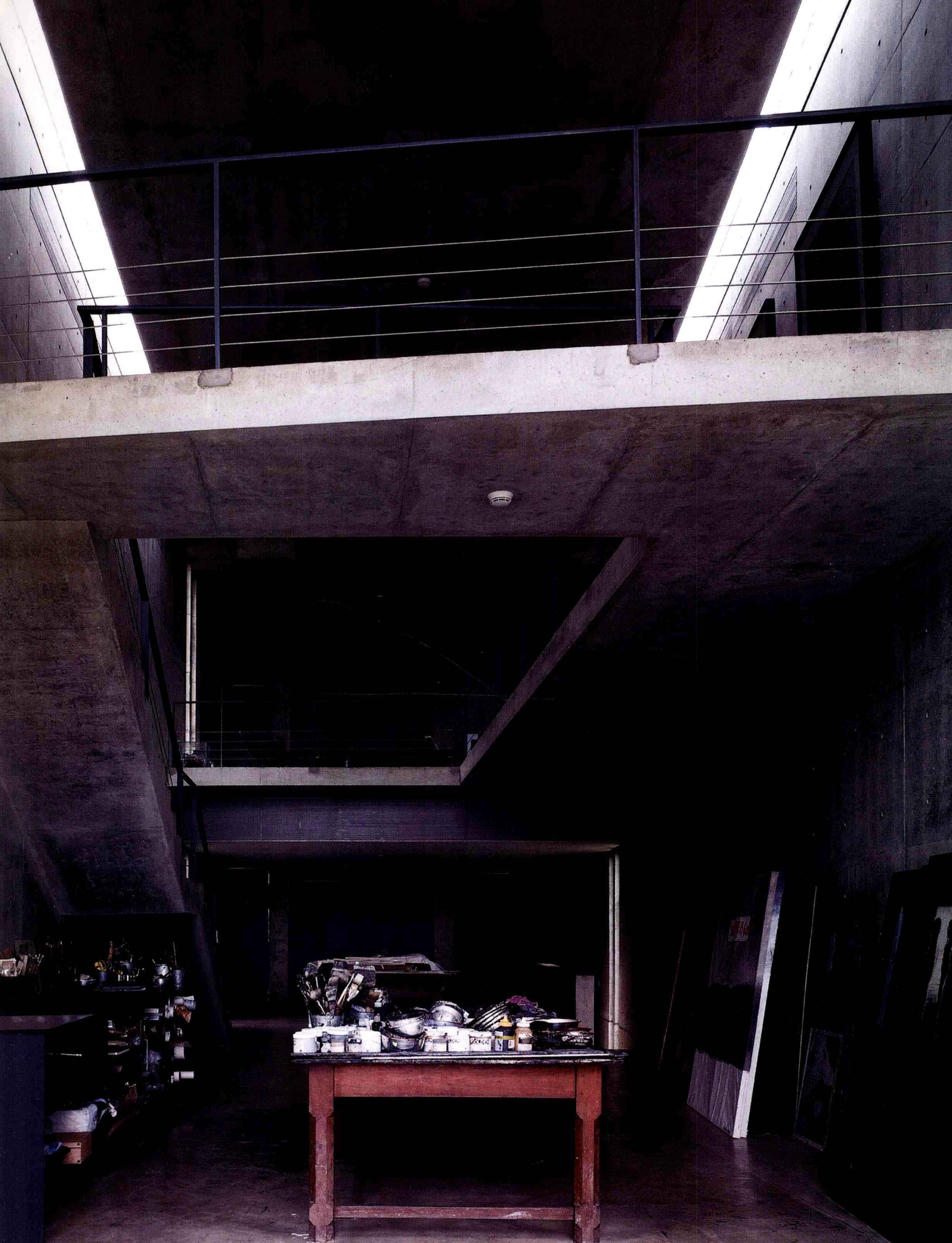
1階アトリエ。棚には夫人の仕事道具が並び、描きかけの作品が立てかけられている。自然光のもとで作品制作が行えるように、アトリエの中ほどの両壁面沿いにトップライトが設けられている。2階にはアトリエを立体的に活用するためのデッキが設けられ、ギャラリーとしても使われている。
