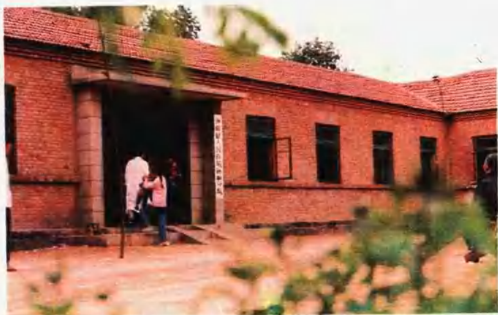
济阳县人民医院孙耿分院
