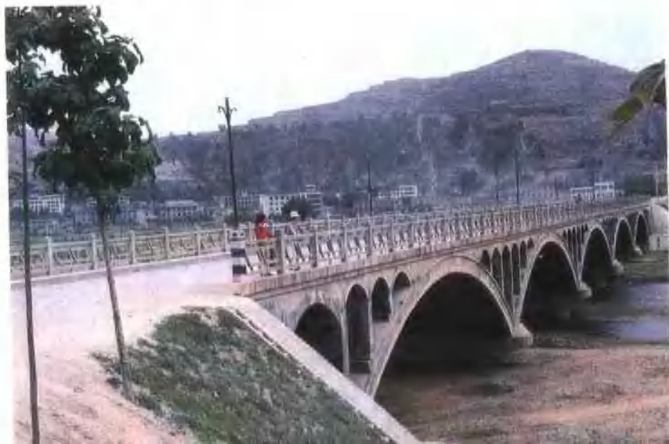
崇信梁波河大桥
