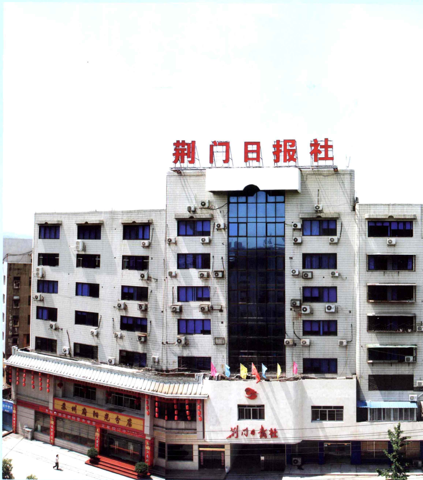
荆门市象山二路3号荆门日报社综合楼(1994年9月—2010年12月)
