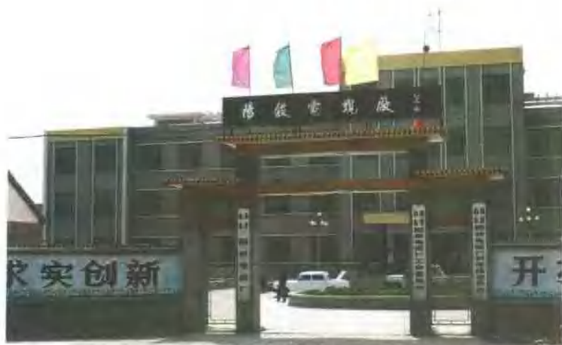
山东阳谷电缆厂
