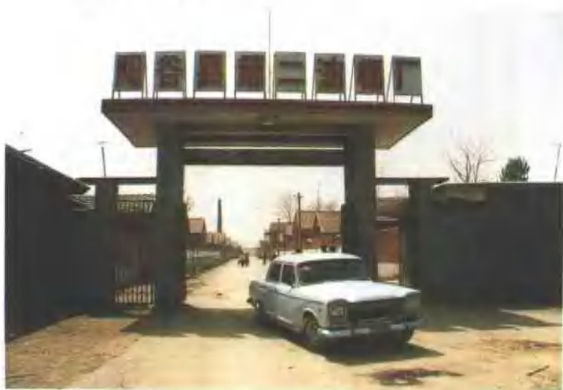
阳谷县第二油棉厂厂区
