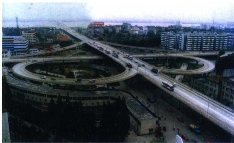
四通八达的黄浦路立交桥
