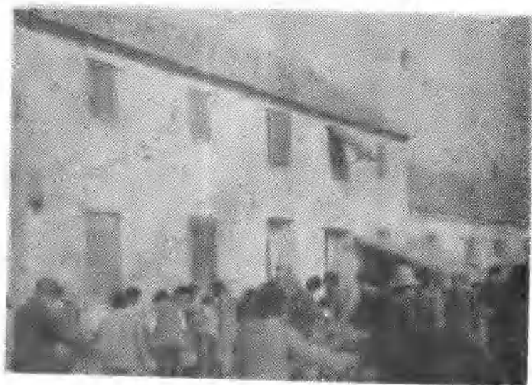
1948年6月21日至23日，中国人民解放军苏北兵团35旅一举拔除新坝、龙苴、大伊山、董集等大小据点10处。大伊山解放，灌云县委、县政府机关迁入大伊山办公。照片为县委、县政府驻伊山旧址。
