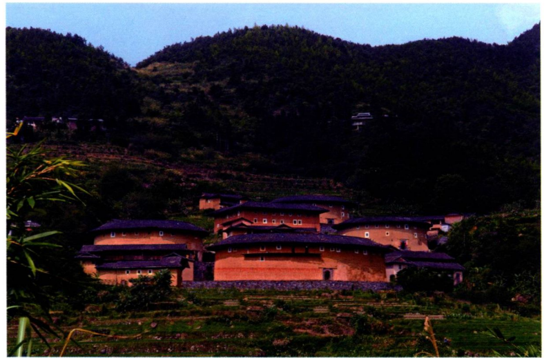
仰视田螺坑土楼群 Looking up at Tianluokeng Tulou Cluster
