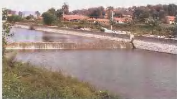
辛庄镇石湾子村拦河坝
