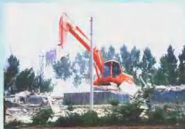
强制拆除违法占地建筑
