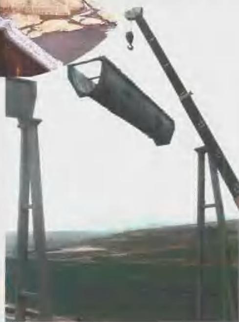
杨横水库渡槽吊装
