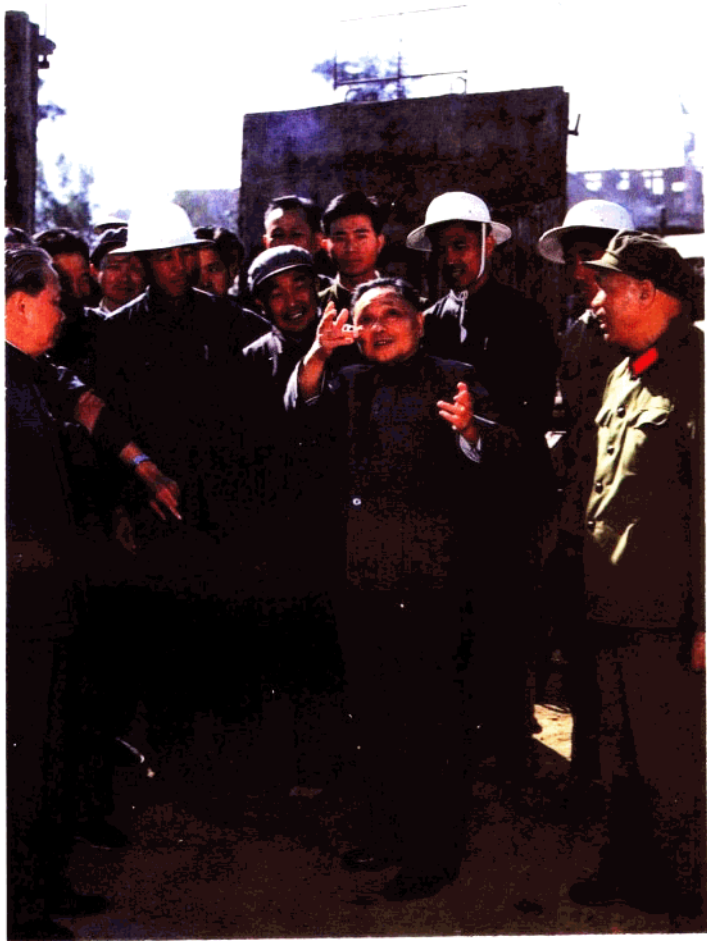
1978年9月19日，邓小平同志视察我市住宅建筑工地。
