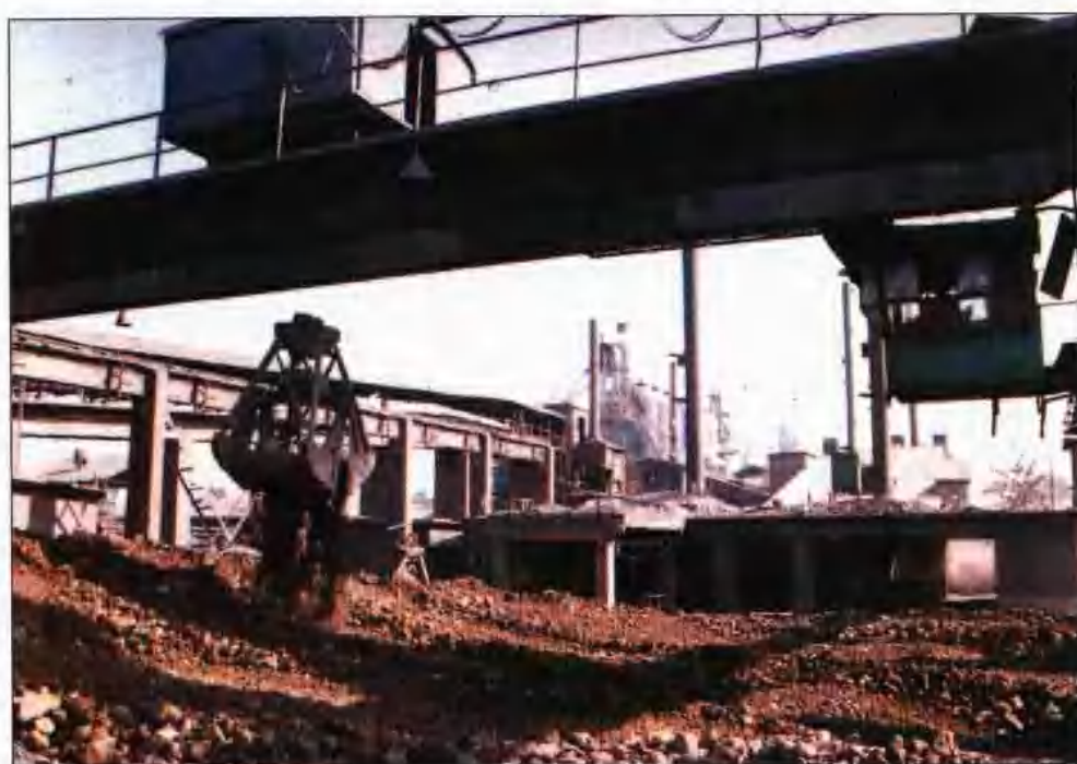
破碎系统一角
