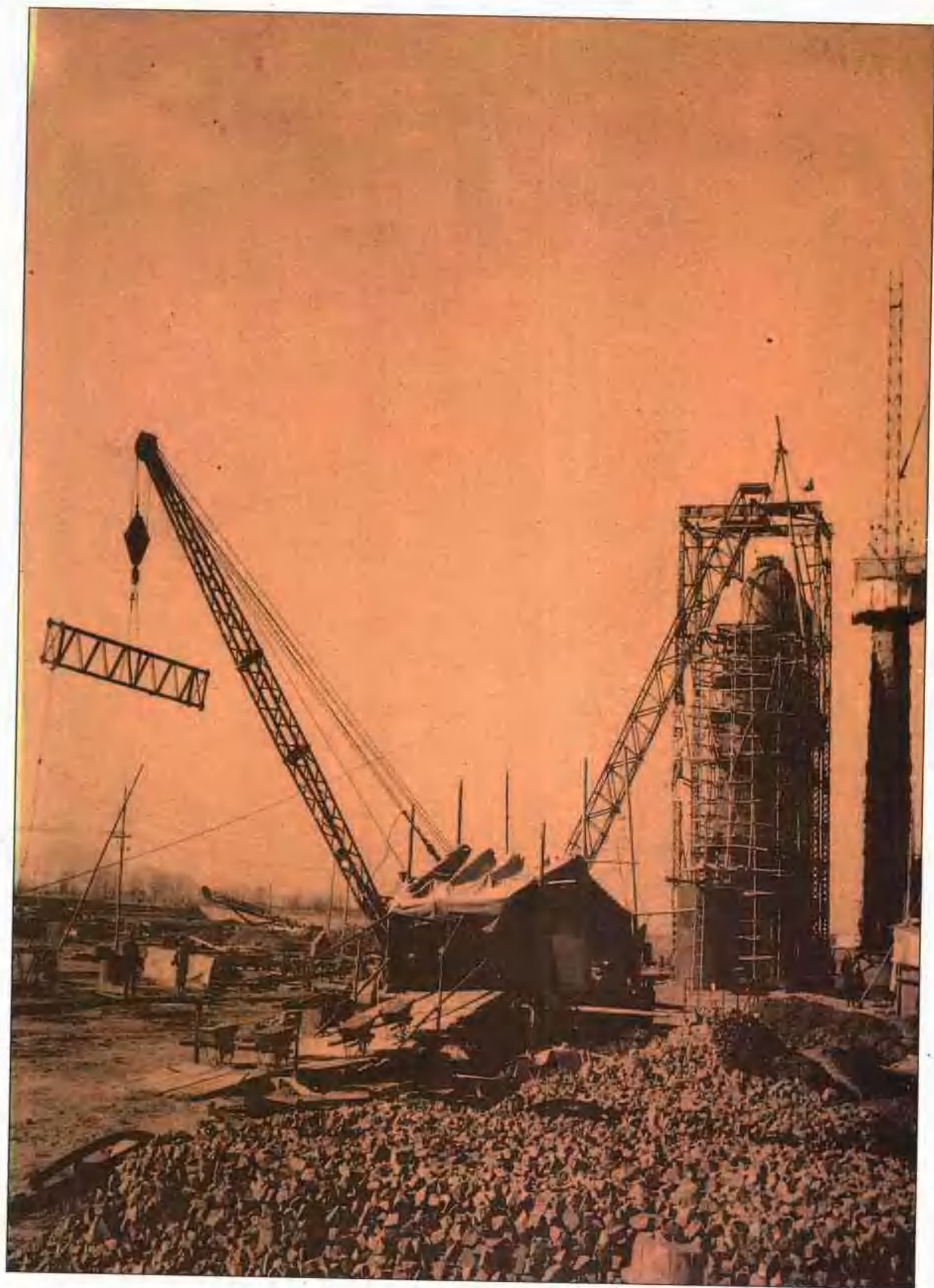
三号高炉在建设中
