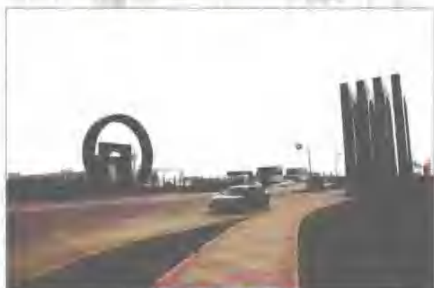
屯留工业园区
