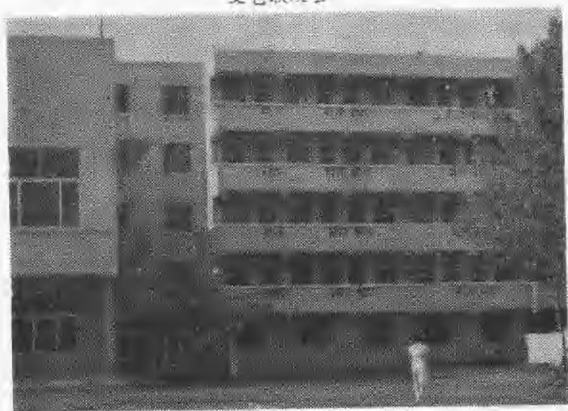
内有学员宿舍、餐厅、礼堂的综合楼
