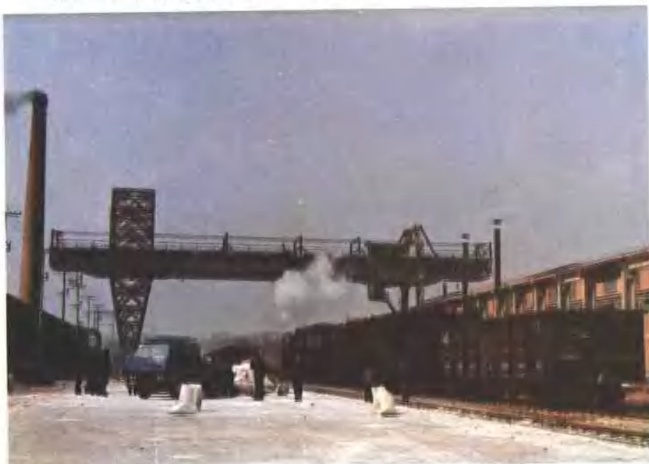
图 3—12 厂内铁路专用线及30吨龙门吊
