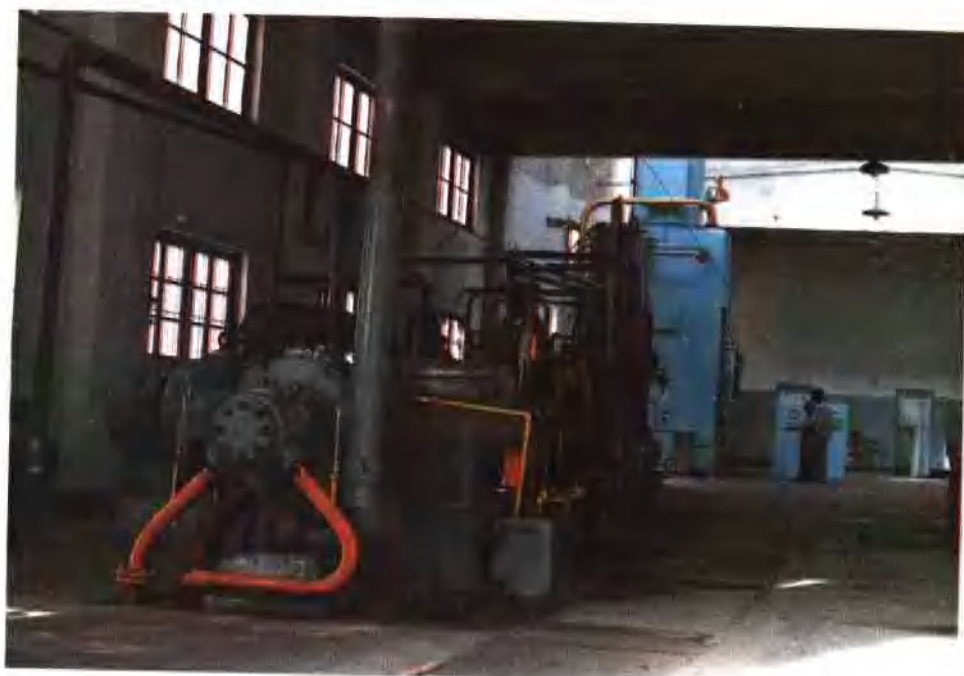
图 3—11 制氧车间内景
