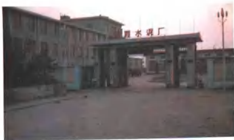
山东省栖霞县水泥厂
