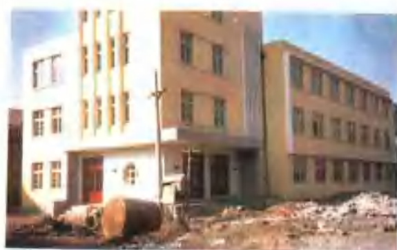
烟台市建筑材料科学研究所
