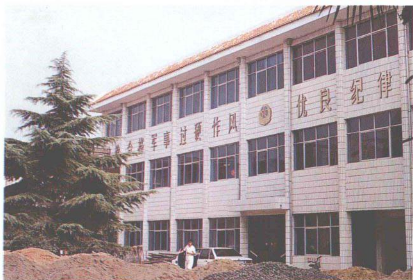
4. 县人武部办公楼
