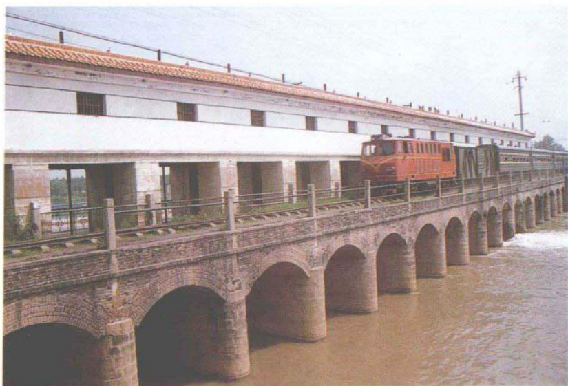
6.1958年张保太、王殿安任书记、县长时修建的北关贾鲁河拦河闸
