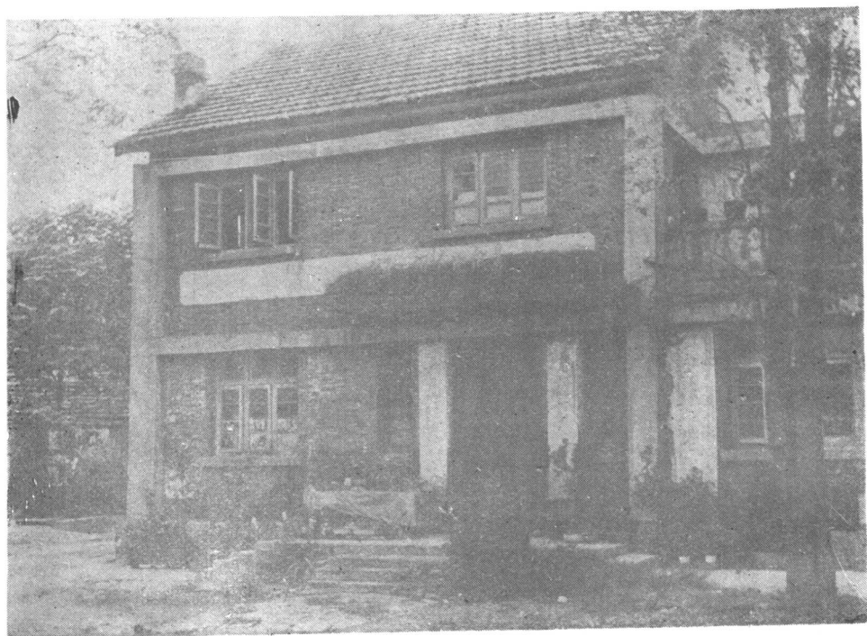
总前委驻丹阳旧址（原小楼为三间一厢，右边的建筑为 华东局
