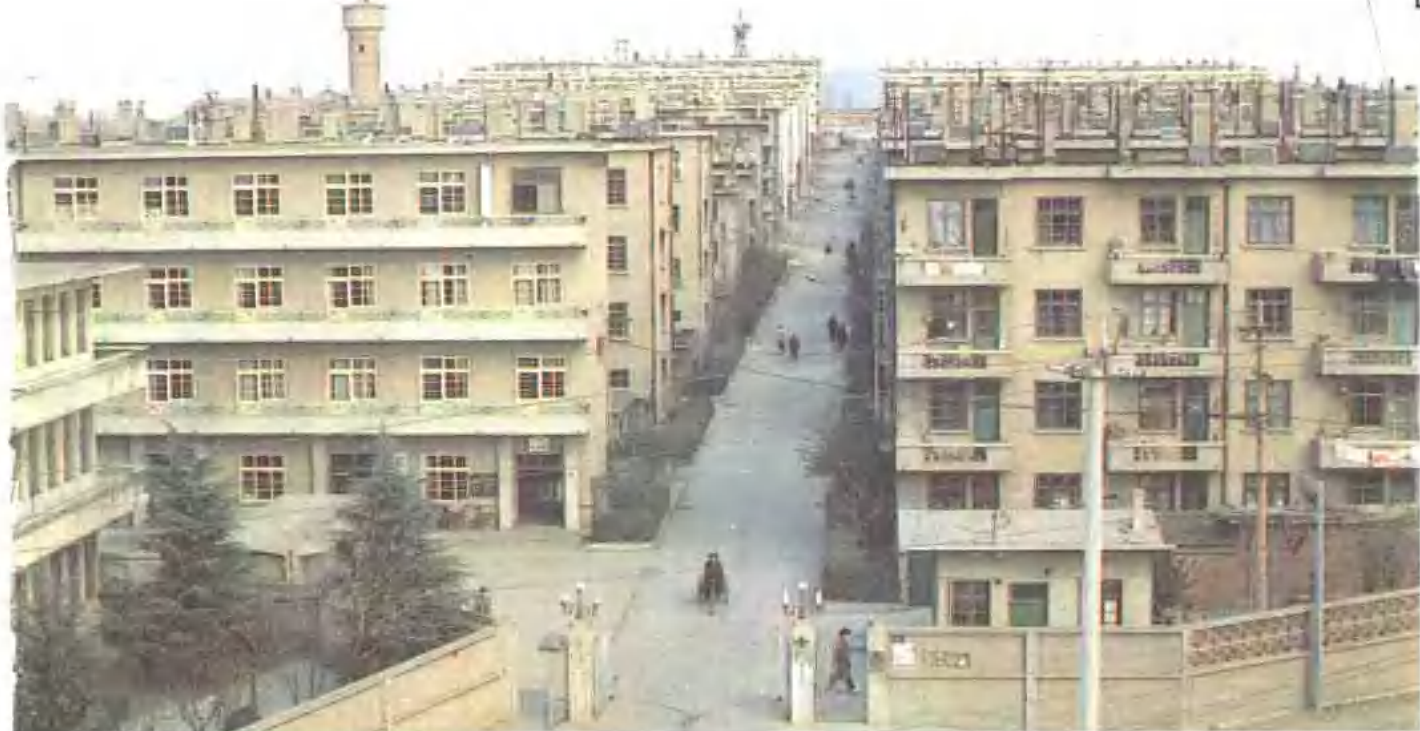
一座座職工宿舍樓拔地而起
