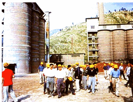
△县水泥厂拍买改组为中盛水泥厂以来，企业发展充满生机
