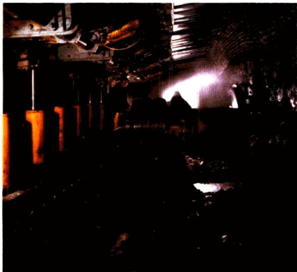
兴隆庄煤矿综采工作面
