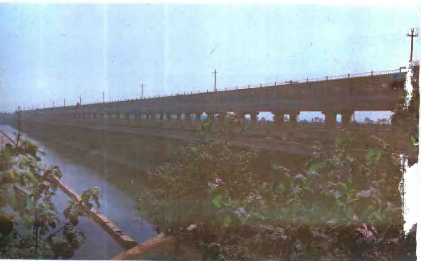
东平湖石洼分洪闸
