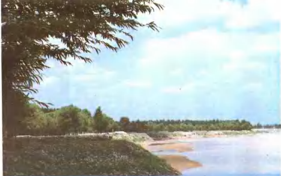
济阳邢家渡控导工程
