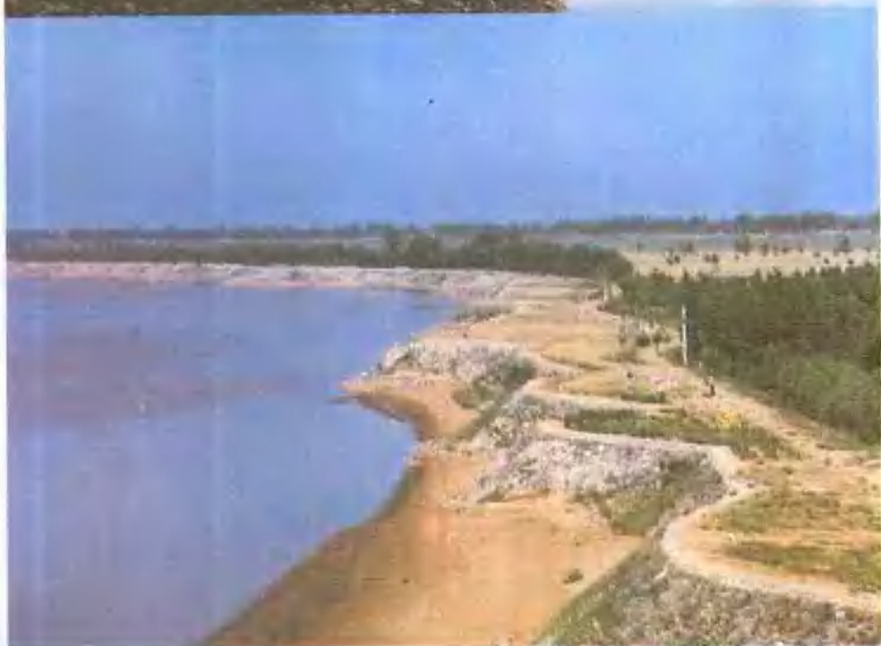
齐河八里庄控导工程
