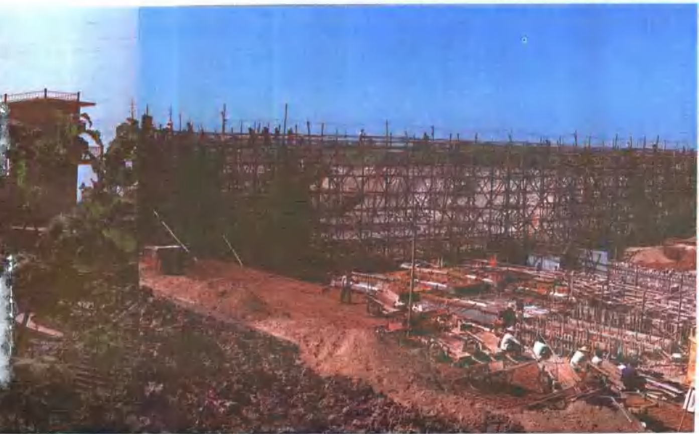
施工中的东平湖司垓退水闸
