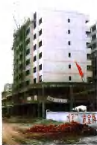
正在新建的三溪集团泸州巨龙房地产开发公司办公大楼
