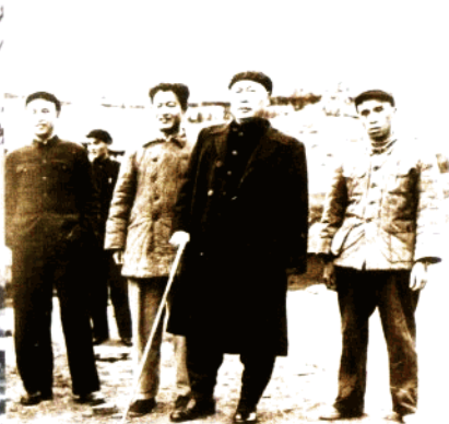
▲ 陈毅元帅在花溪水库大坝 (1959年11月)
