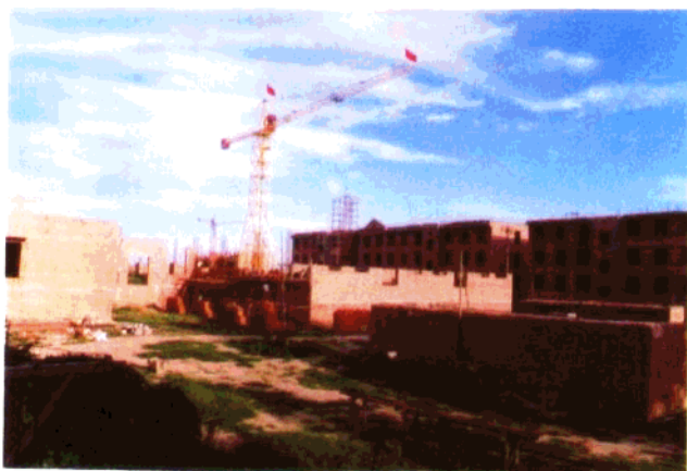
一中建设工地。1995年经县委、县政府批准，县教委着手进行宁晋一中搬迁工作，该工程按国家重点高中标准设计，占地 145 亩，建筑面积 3 万平方米，总造价 3000 万元。
