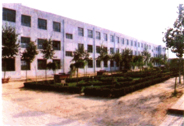
二中教学楼，1989 年，教委筹措资金 80 万元（贷款 7.5 万元，县财政拨款 5 万元）建成二中教学楼，建筑面积 4000 平方米。
