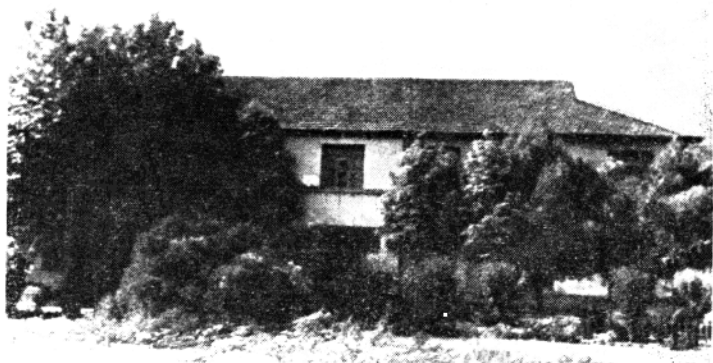
凤阳县委办公楼
