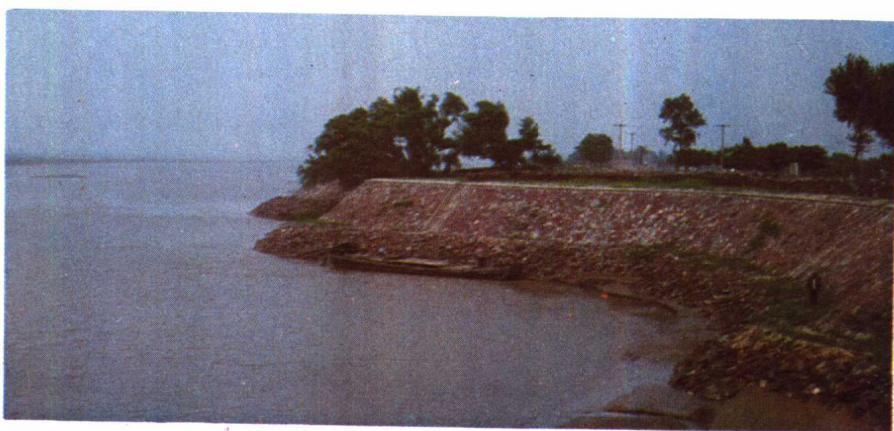
黑岗口险工盖坝 马刚 摄
