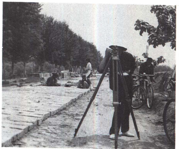
铺设堤顶硬化路面 胡锡焮 摄
