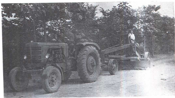
用刮板机刮平堤顶 徐尧虎 摄
