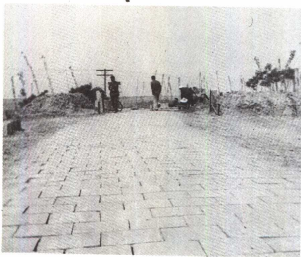
竣工后的堤顶硬化路面 胡锡焮 摄
