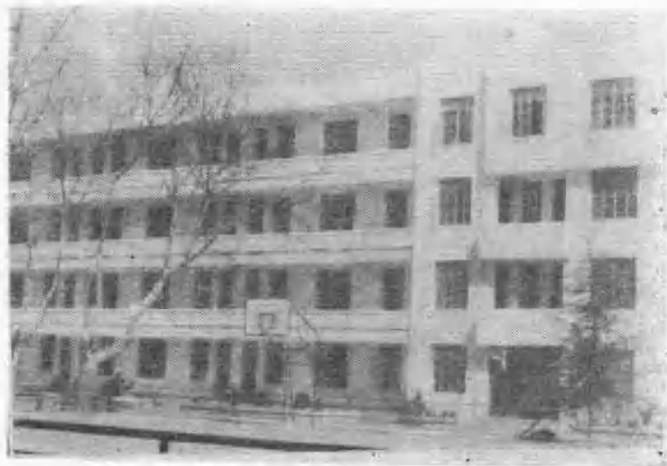
南京第九中学新建的教学、实验楼
