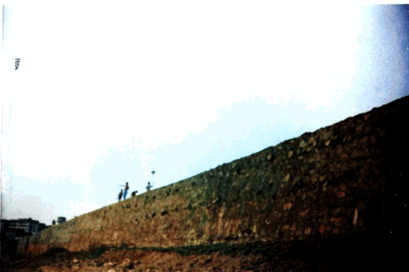
10.15 米(高) \times 9.1 米(宽)的宁江城区东堤挡土墙
