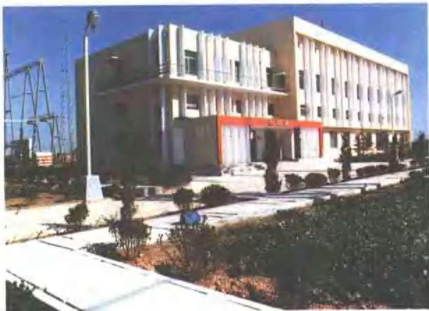
500千伏潍坊变电站主控楼
