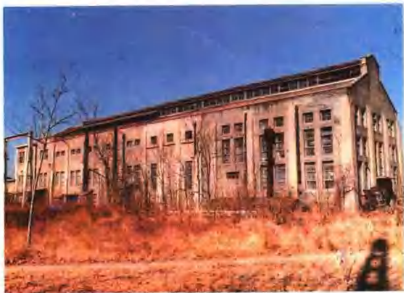
潍坊发电厂老厂房
